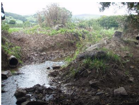
Bankside erosion at Plas yn Rhal
